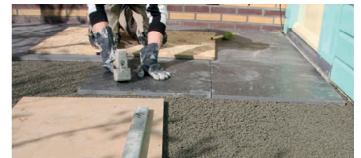
6. Einklopfen der Fliese in den Drainagemörtel (frisch in frisch)
