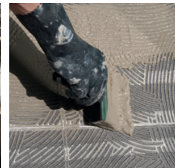
5. Auftragen Haftschlämme DM auf der Fliesenunterseite
