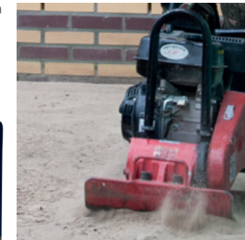
1. Verdichten des Unterbaus
