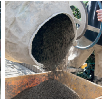
2. Mischen von Bindemittel und Edelsplitt im Betonmischer
