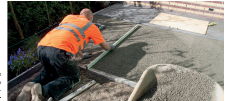
3. Einbringen des Drainagemörtels und Abziehen auf eine Schichtdicke von 4 cm
