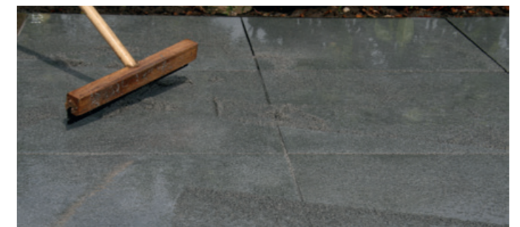
7. Verfugen des Keramikbelags mit Pflasterfuge 1K Flex
