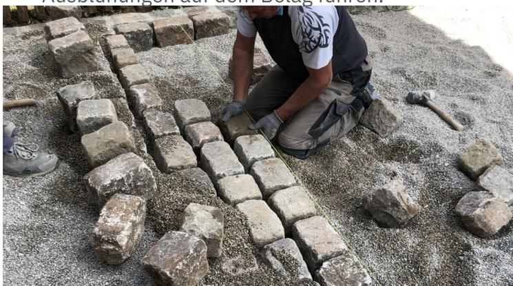
„gebundene Bauweise: Sickerbeton der Körnung 2-6 mm (250 kg Zement / m<sup>2</sup>)
